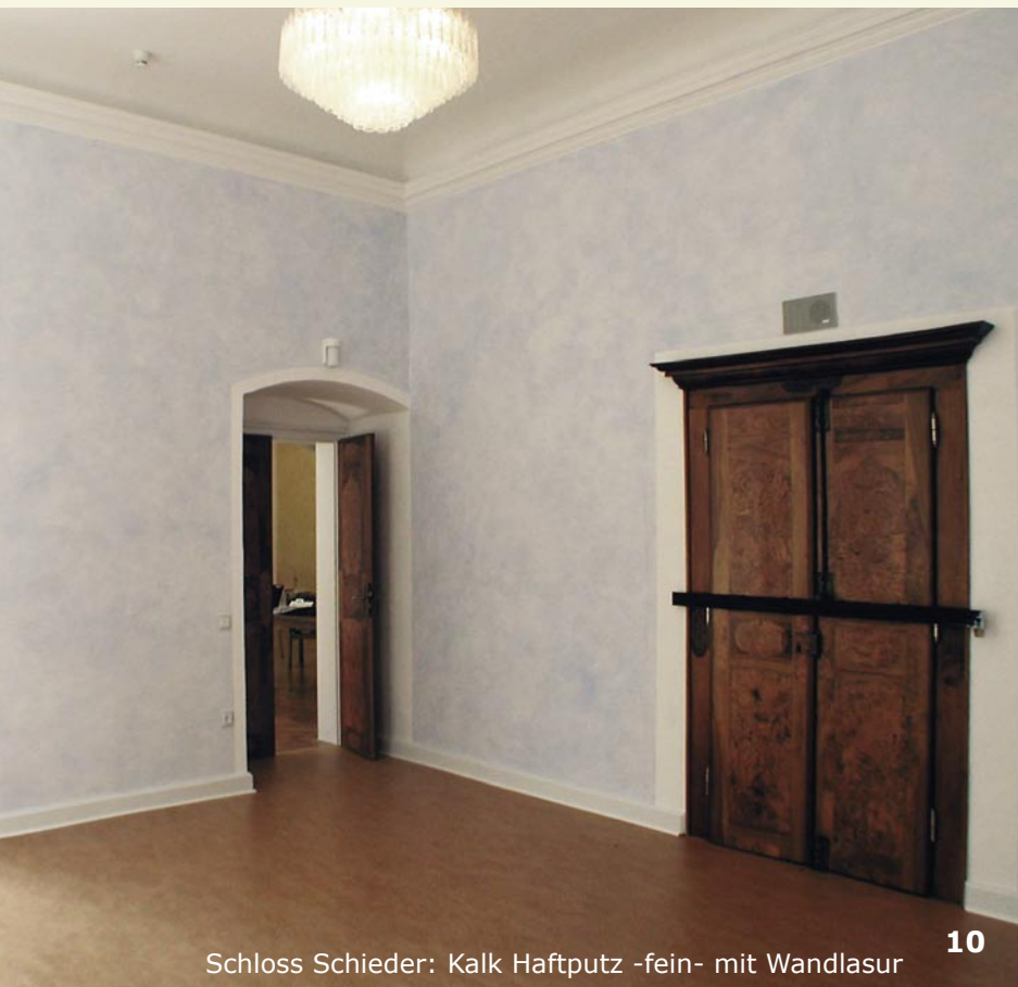
Kalk Haftputz -fein- mit der Glättekelte aufgetragen
