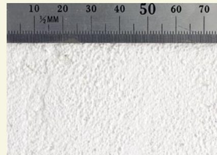
Kalk Haftputz mit der Glättekelte aufgetragen
