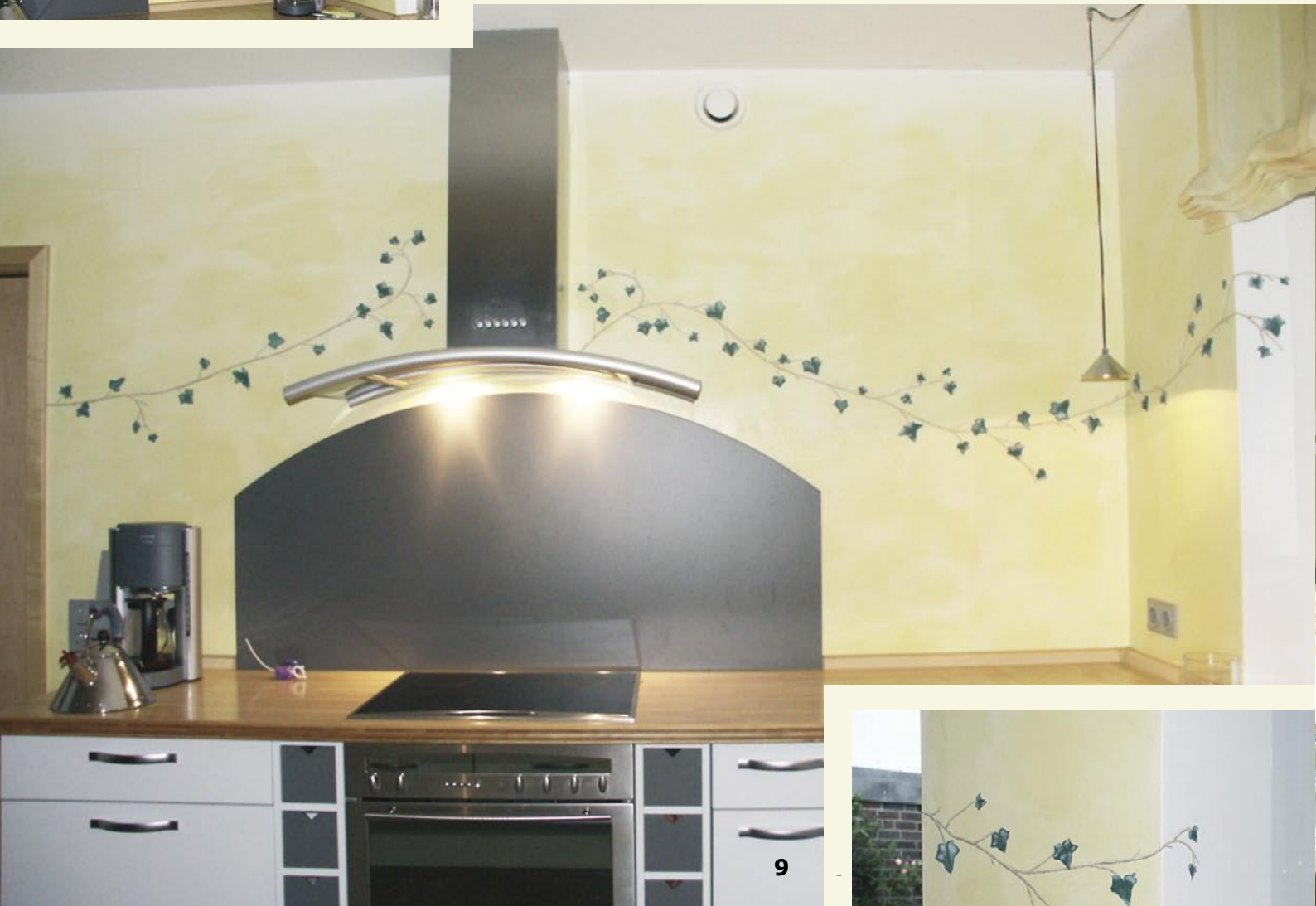
Wandgestaltung mit Wandlasur-Bindemittel auf Kalk Haftputz
